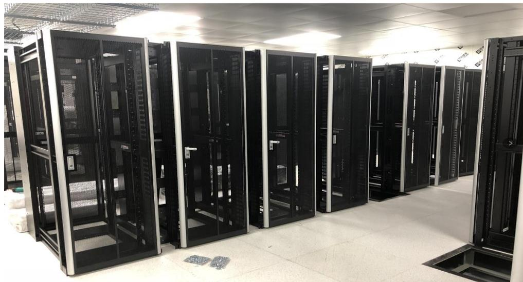
**奉贤校区数据中心**第一阶段建设任务完成：调试、上线了核心交换机、接入交换机，实现了徐汇、奉贤数据中心的SDN组网，提高了奉贤数据中心的网络性能，简化了网络结构，加强了安全防护。
